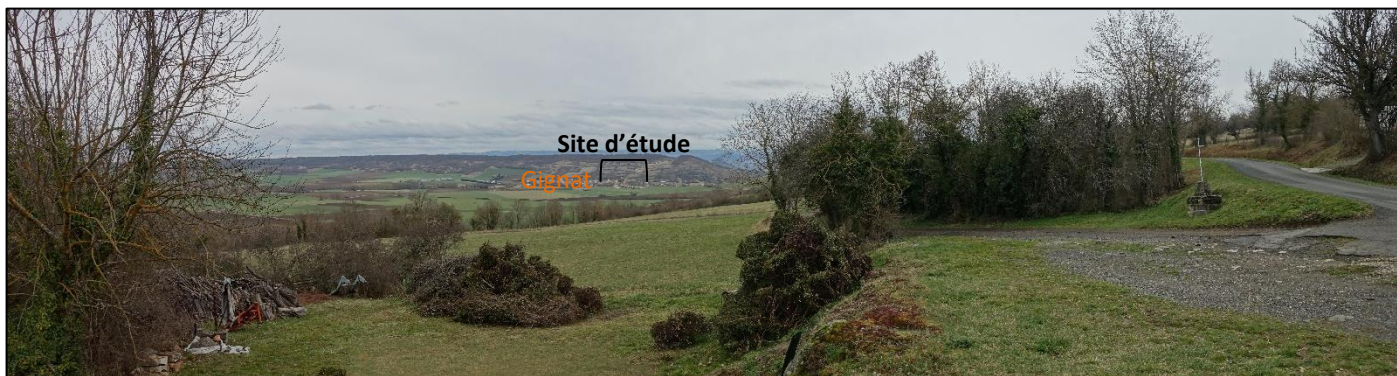
4 – Point de vue depuis la limite Sud du bourg de Villeneuve, à l'Ouest du site d'étude
