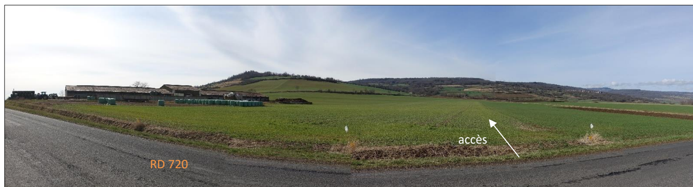
Accès au site de méthanisation
